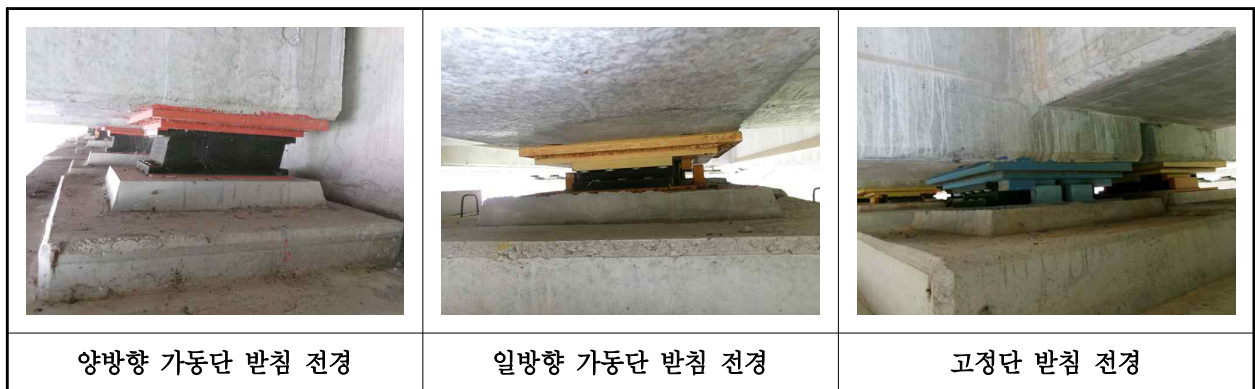
【사진 29.3.37】 교량받침 전경
