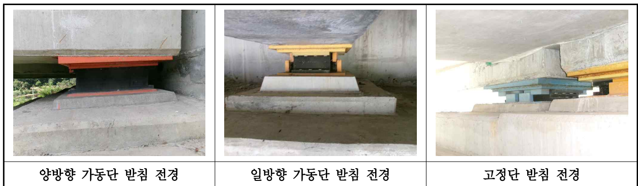
【사진 29.3.12】 교량받침 전경
