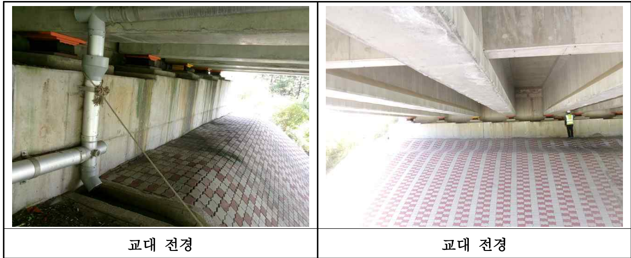
【사진 29.3.8】 교대 전경
