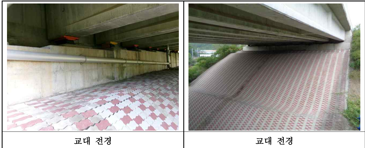
【사진 29.3.33】 교대 전경
