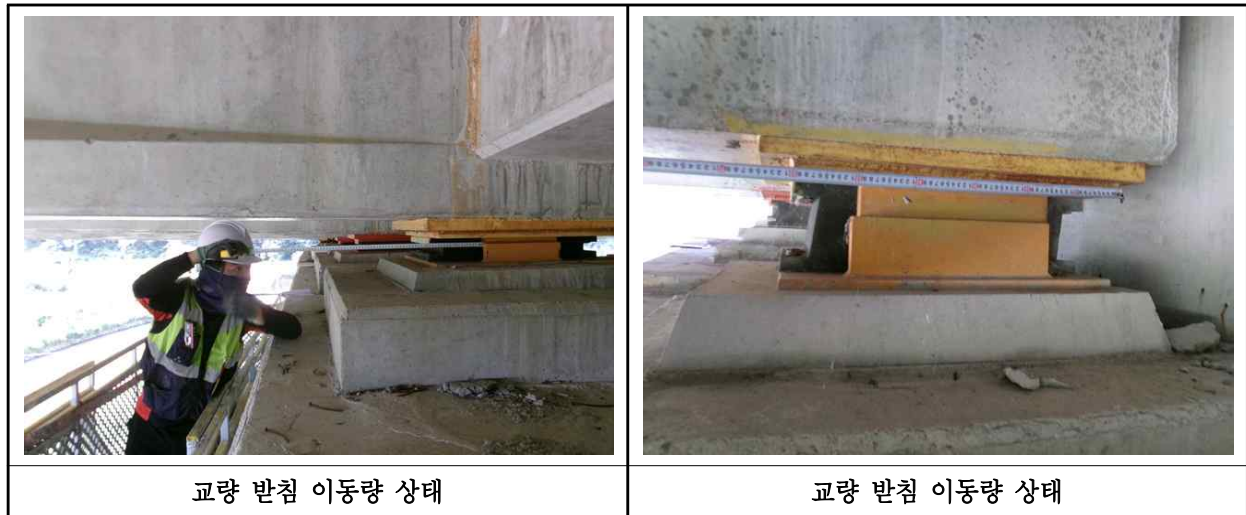
【사진 29.3.15】 교량받침 이동량 상태
