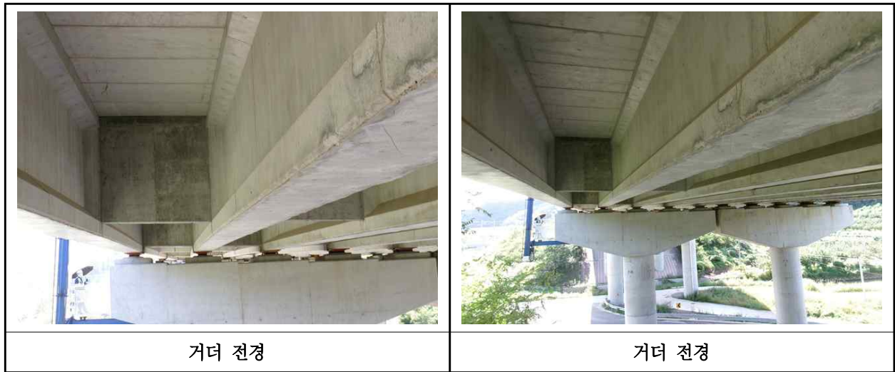
【사진 29.3.4】 거더 전경
