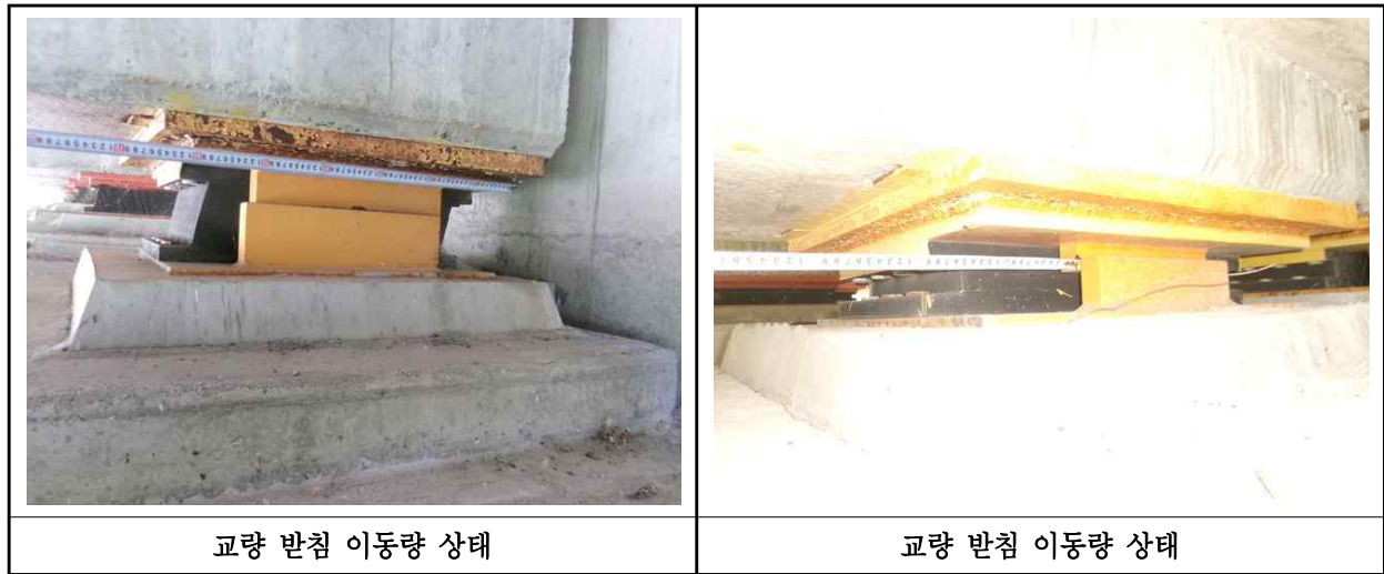
【사진 29.3.40】 교량받침 이동량 상태
