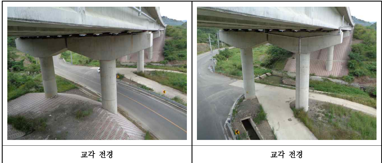
【사진 29.3.35】 교각 전경
