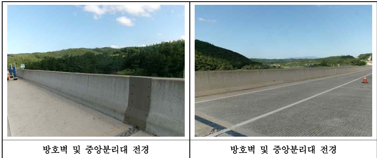
【사진 29.3.23】 방호벽 및 중앙분리대 전경
