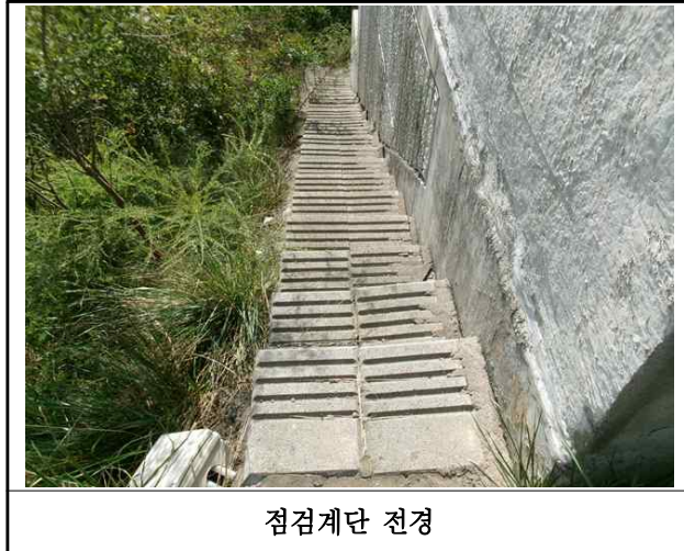
【사진 29.3.25】 교량 점검시설 전경
