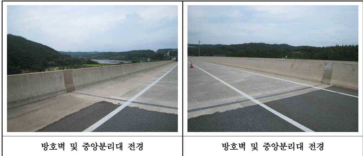
【사진 29.3.48】 방호벽 및 중앙분리대 전경
