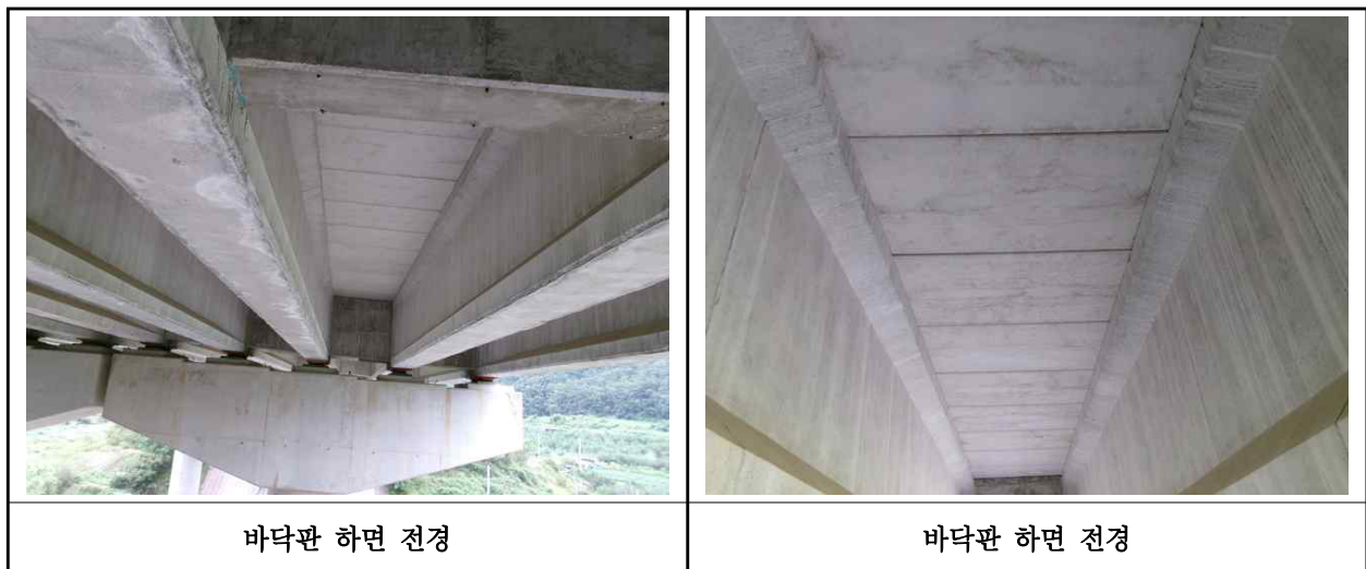
【사진 29.3.27】 바닥판하면 전경
