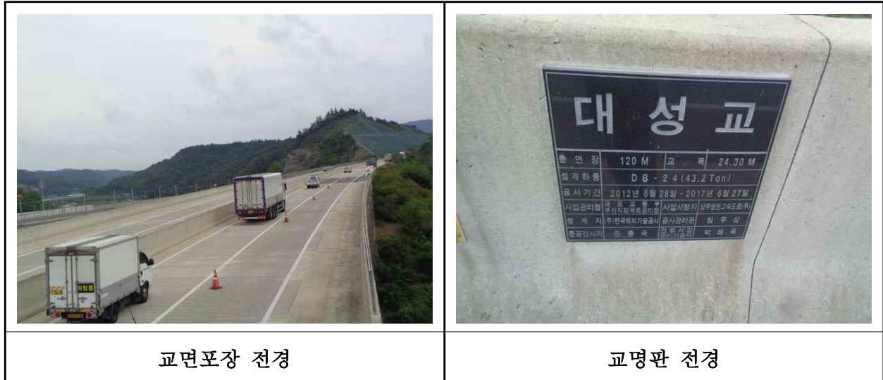
【사진 29.3.44】 교면포장 전경
