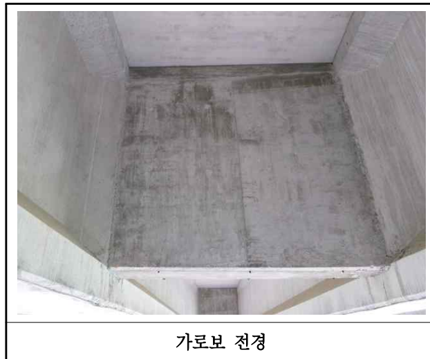
【사진 29.3.31】 가로보 전경
