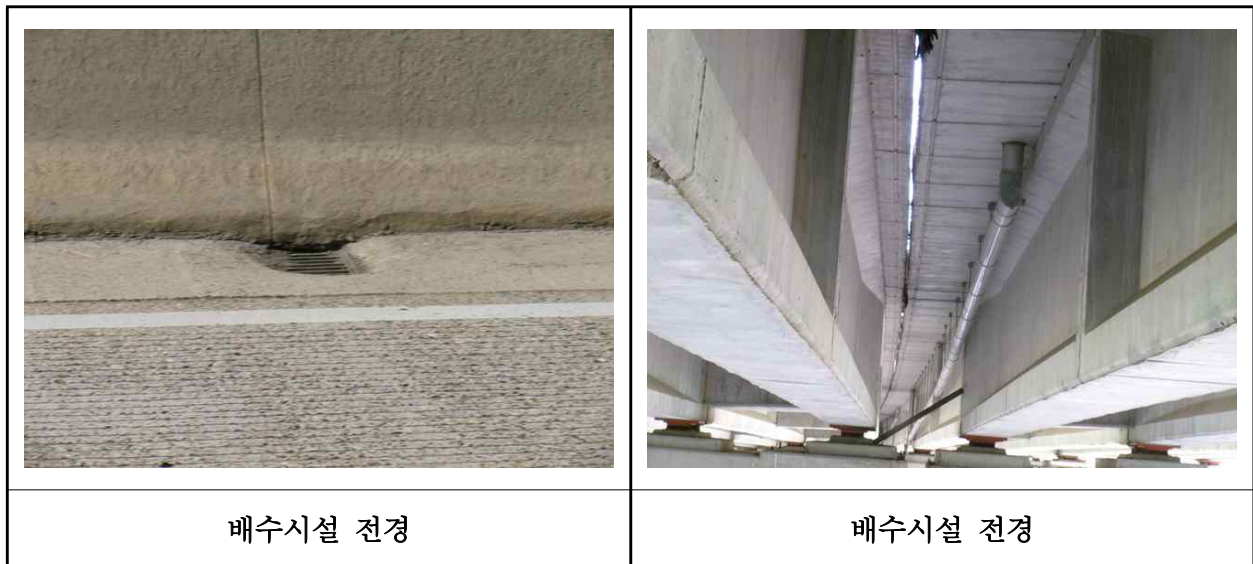
【사진 29.3.21】 배수시설 전경
