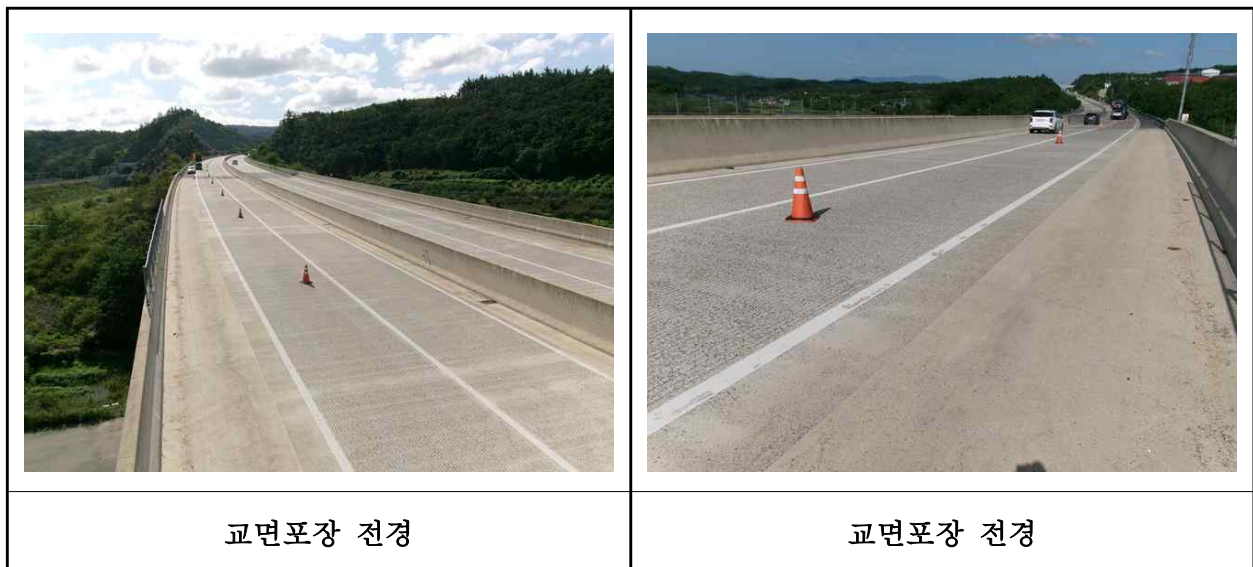
【사진 29.3.19】 교면포장 전경
